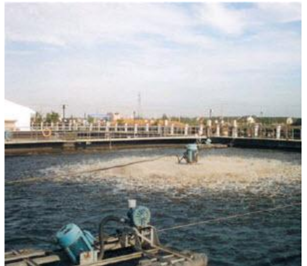
เครื่องเติมอากาศแบบอัดฟุ้ง AIRE-O2 TRITON® ซึ่งประหยัดพลังงานและทำงาน 2 สถานะ (เติมอากาศและกวนผสม) ทำงานร่วมกับเครื่องเติมอากาศแบบรอบเร็ว AIRE-O2 TURBO®
