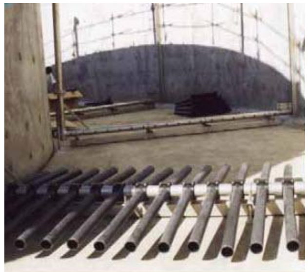
AQUATUBE Diffusers พร้อมโครงข่ายท่อในระหว่างการติดตั้ง
