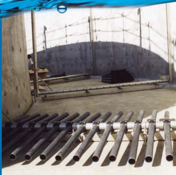
Raquettes Aquatube en cours d'installation.
